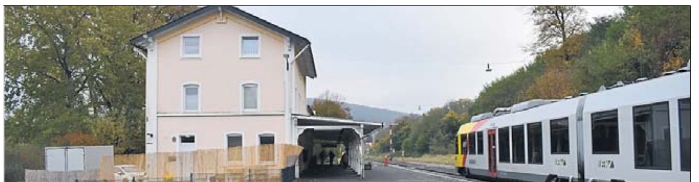
Am Bahnhof gibt es dringenden Sanierungsbedarf.
